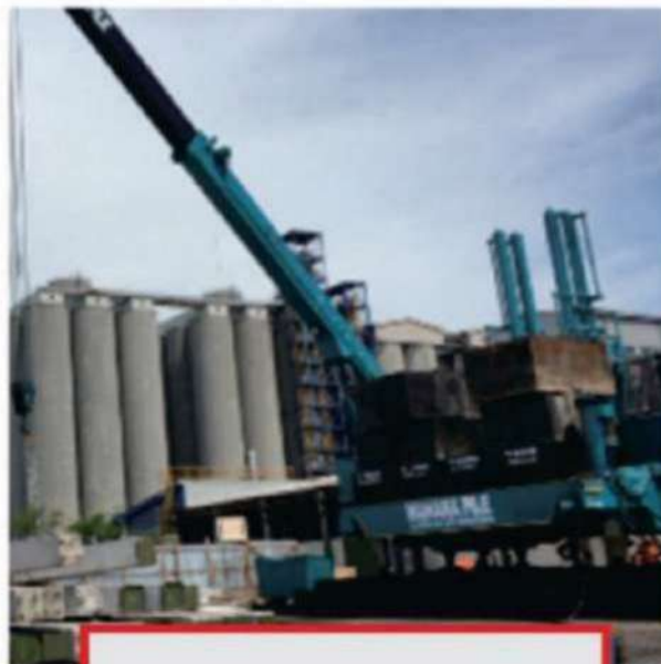
PT. INDOFOOD SUKSES GI 150 kV 32 MVA
